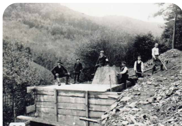
Construction du réservoir (maison forestière)
